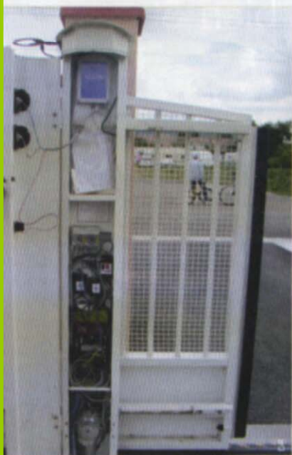
Ce lotissement sécurisé de Pamiers est le premier site français équipé de la « Novapass Box » : un boîtier doté d'un modem GSM quadribande qui déclenche l'ouverture des portails après reconnaissance du numéro de téléphone mobile du résident.
